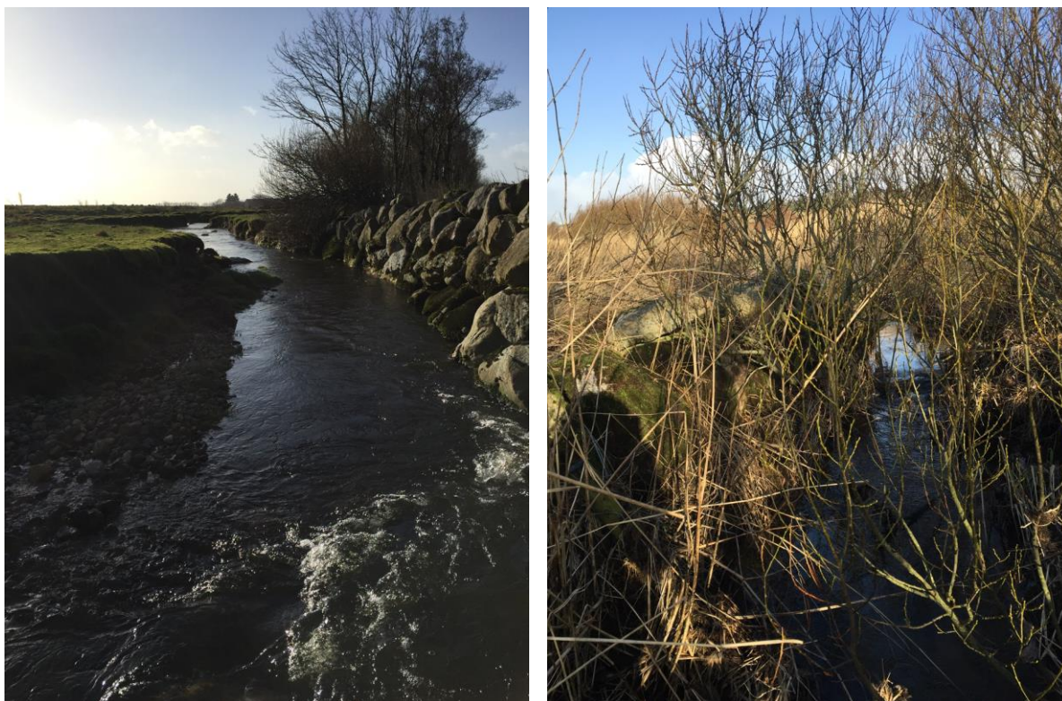
Figur 5.3. Årlandsåna. T.v: Den undersøkte bekkestrekningen går over et beiteområde. Erosjonen er omfattende i de bratte sidekantene. T. h. nedre del av «samlebekken» som renset anleggsvann vil bli sluppet ut i.
